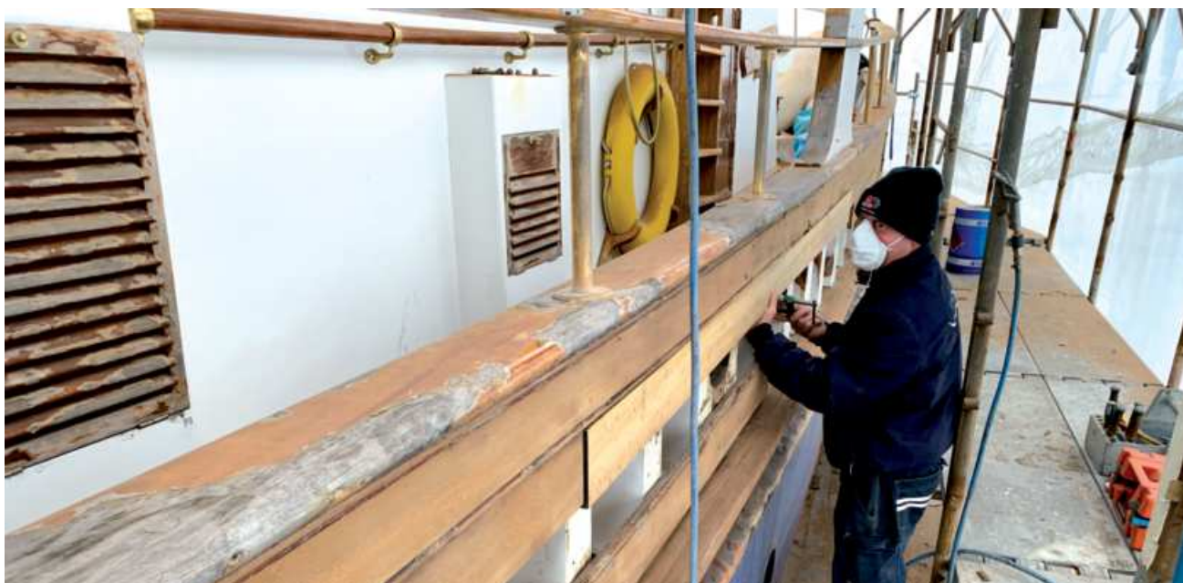
Restauro in corso alla navetta Tabua presso i Cantieri Navali di Sestri
